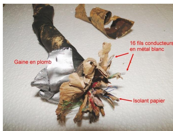
Vue 2 : examen intérieur du câble
