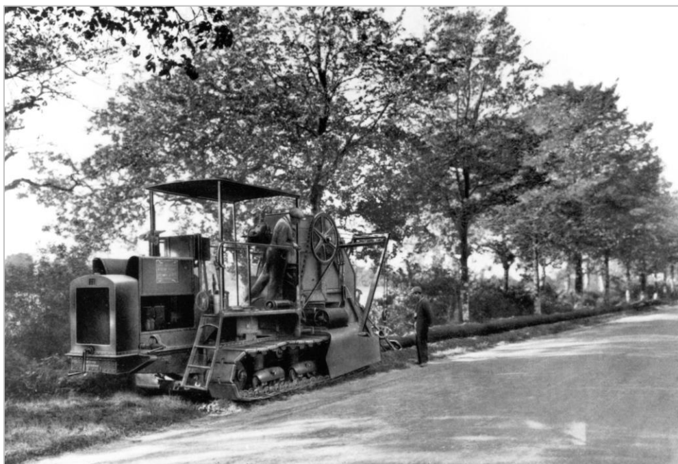
Vue d'une trancheuse lors de la pose d'un câble interurbain le long d'une route, en 1943. Photographie PTT - 1943 - Collection Claude Rizzo-Vignaud
