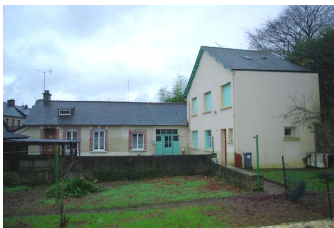
La maison basse abritait la station électrique
