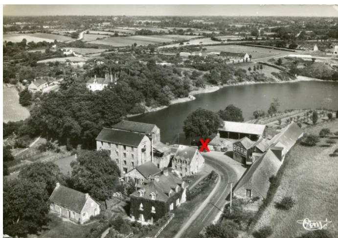
Vue aérienne du pont de la Forge. Le X indique le lieu précis de l'accident (CPA collection privée)
