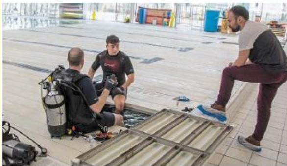
Mercredi et jeudi, la piscine des Ondines était fermée pour le remplacement des douze câbles du fond mobile par deux plongeurs suédois. | PHOTO : CLUST-FRANCE
