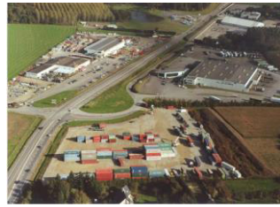
ZONE D'ACTIVITES A ENERGIE POSITIVE
