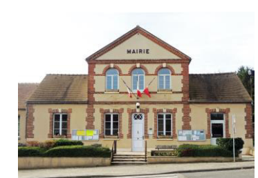
RENOVATION BATI PUBLIC Conseil en Energie
